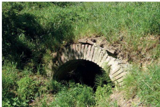
La fontaine avant travaux
