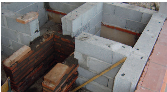
Construction de l'assise
