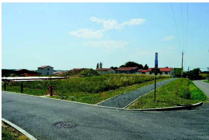
Construction de lotissement le Souleilla de l'Hom, sur le coteau sud du centre bourg historique. Les cheminements inter- et intra-quartiers sont valorisants pour le quartier. Néanmoins, les aménagements urbains et la pré-végétalisation sont majoritairement absents.
