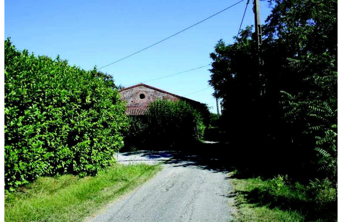
Bâti de caractère
