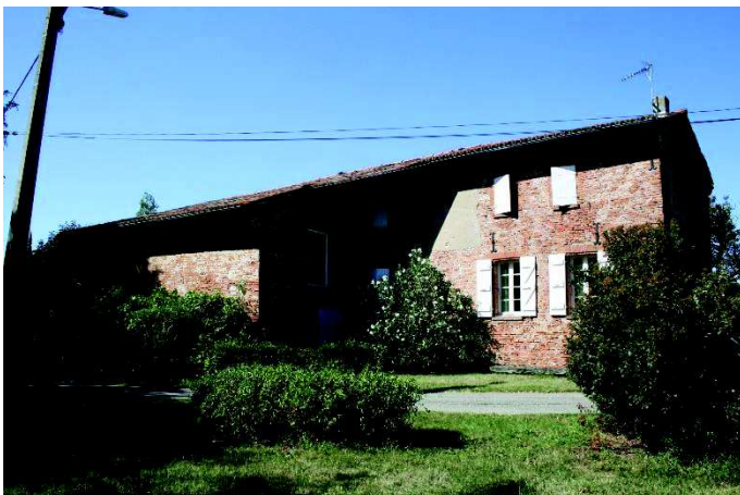
Bâti de caractère
