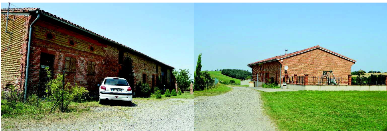
Exemple d'ancien et de récent en harmonie. Impasse avec une ancienne réhabilitation (gauche) et une construction récente (droite).
