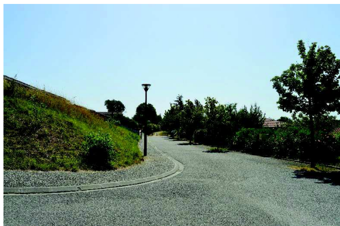
Lotissement à l'entrée ouest du village où les aménagements urbains (alignement d'arbres, éclairage et trottoir) sont réalisés de manière satisfaisante.
