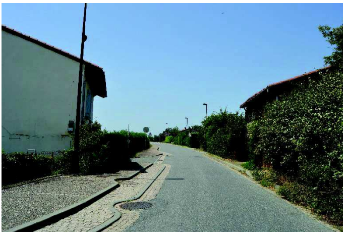
1. L'entrée ouest du village. Une végétation débordante dissimule souvent le bâti historique articulé le long de la RD 24. L'aménagement des accotements renforce donc le caractère urbain ici très présent.
